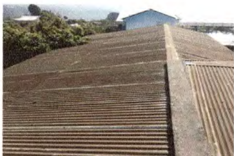
Foto1: Sustrucción de lámina, por lámina troquelada Aluzinc Calibre 26, sustrucción de capote
