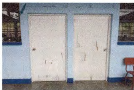
Foto 3: SUSTITUCIÓN DE PUERTAS
