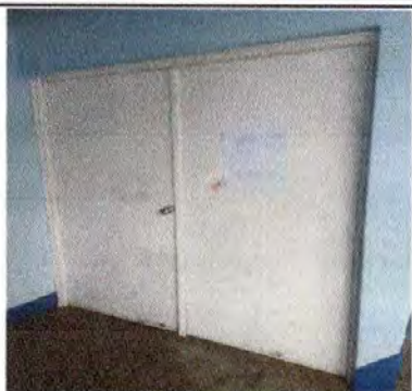
Foto1: SUSTITUCIÓN DE PUERTAS
