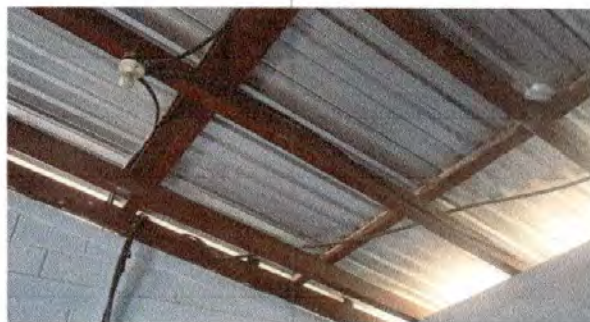
Foto 4: REPARACIÓN DE SISTEMA ELÉCTRICO
