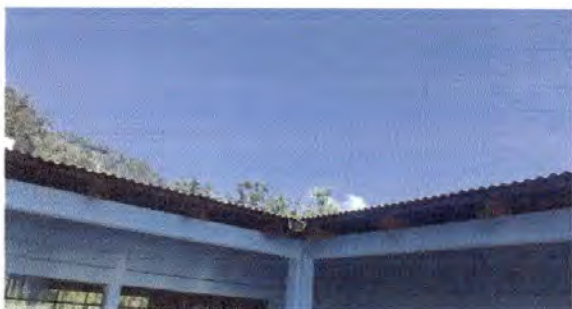
Foto1: Sustrucción de canales de pvc
