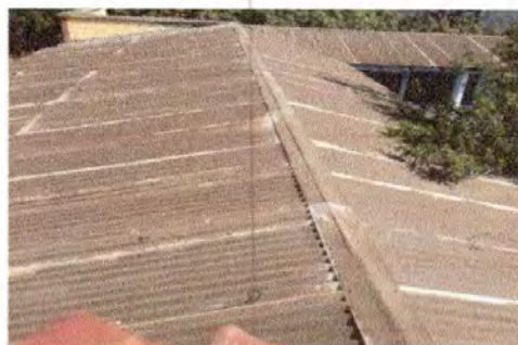
Foto1: Sustrucción de lámina, por lámina troquelada Aluzinc Calibre 26, sustrucción de capote
