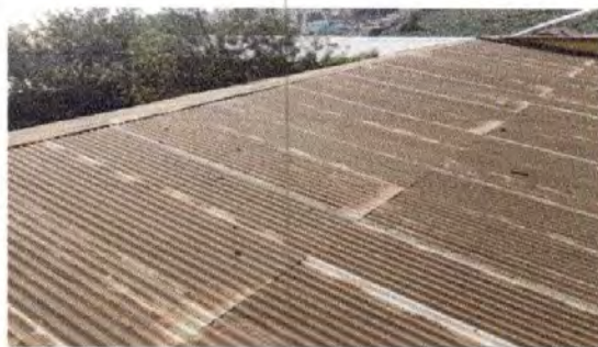
Foto1: Sustrucción de lámina, por lámina troquelada Aluzinc Calibre 26, sustrucción de capote
