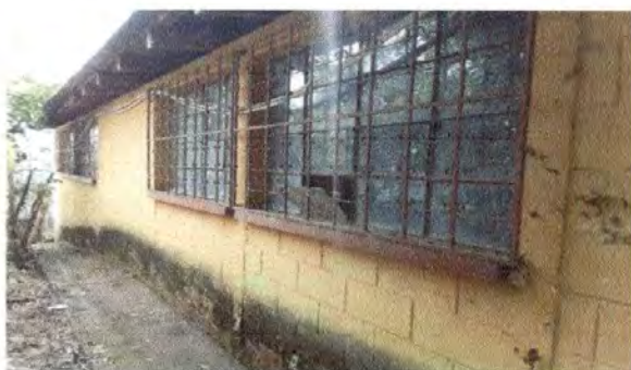
Foto1: Pintura en muros exteriores e interiores
