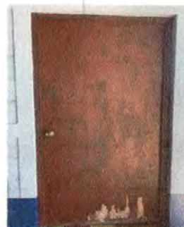
Foto 2: SUSTITUCIÓN DE PUERTAS
