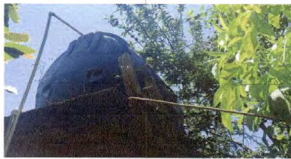
Foto 6: SUSTITUCIÓN DE DEPÓSITO DE AGUA 1100 LT
