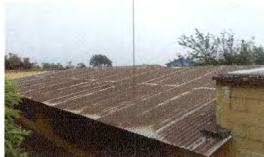
Foto 2: Sustrucción de lámina, por lámina troquelada Aluzinc Calibre 26, sustrucción de capote
